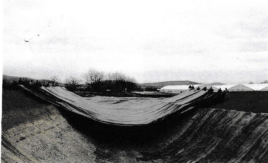
**Schnelle und einfache Verlegung einer 3000 m<sup>2</sup> großen vorkonfektionierten Teichfolie.**
