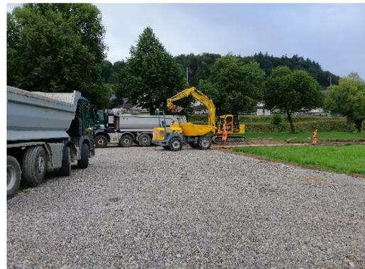
Abb. 2: Bau einer temp. Strasse für einen Grossanlass
