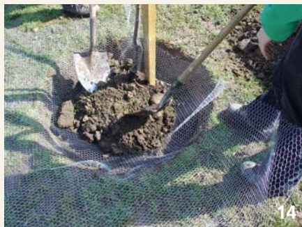
Einlegung eines Drahtgeflecht um den Wurzelballen, bei der Pflanzung von Hochstamm- oder Einzelbäumen
