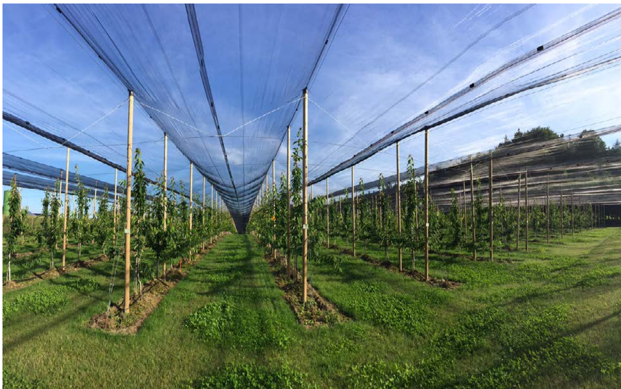
Hagelschutznetzkonstruktion Totaleinnetzung mit Vorhaupt
