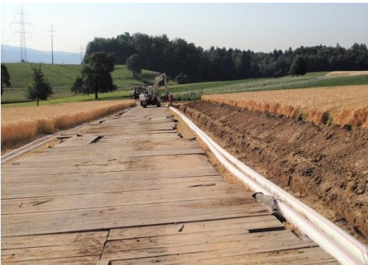
Abb. 1: Bau einer Leitung durch LN (Quelle: Abteilung Umwelt)
