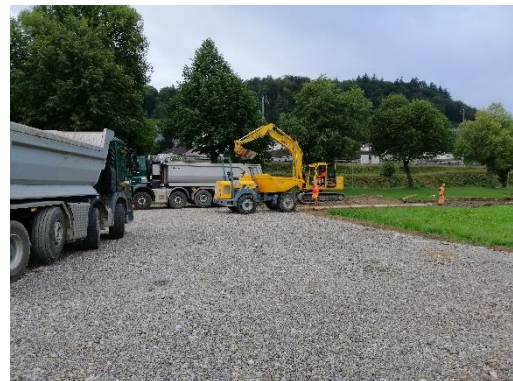
Abb. 2: Bau einer temp. Strasse für einen Grossanlass
