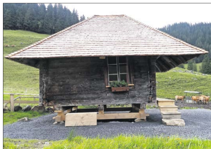
Der älteste Luzerner Käsespycher auf der Alp Trockenmatt im Eigenthal nach der Renovation. (Bild Josef Scherer)
