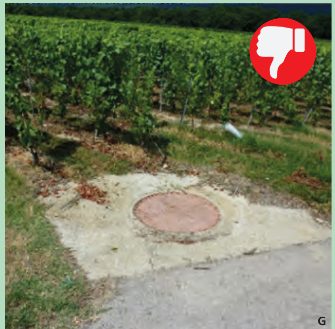
Das Risiko indirekter Einträge über die Kanalisation oder Meteorleitungen muss berücksichtigt werden!
