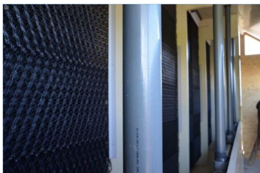
Abbildung 1: Kunststoffwaben einer Abluftreinigungsanlage (Quelle: Merkblatt Abluftreinigungsanlagen Kanton Luzern)
